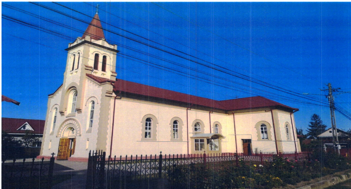
Biserica SF FRANCISC DE ASSISI – a fost finanțată Instalația incalzire biserica cu panouri radiante
